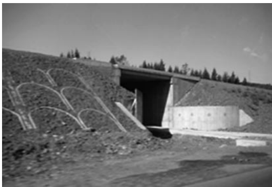
建設中の長春－琿春高速道路
