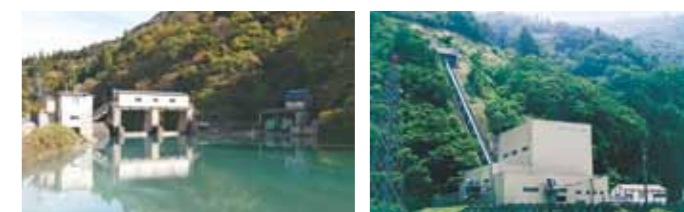
ダム取水口（中山ダム） 水圧鉄管・発電所（大長谷第三発電所）
