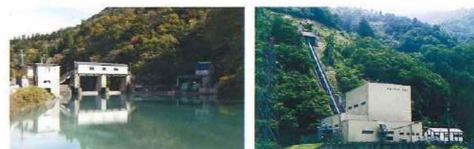
水库取水口（中山水库） 水压铁管、发电站（大长谷第三发电站）
